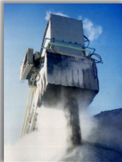
Descarga de banda en apilamiento con aspersores de Niebla Seca formando un anillo.
