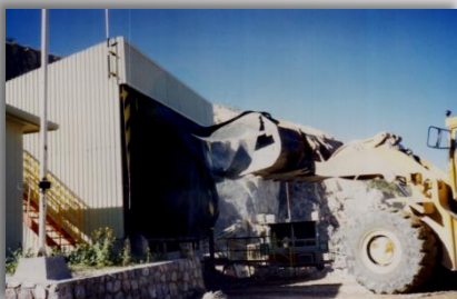
Tolva cubierta con caseta y sistema de Niebla Seca actuado automáticamente.
